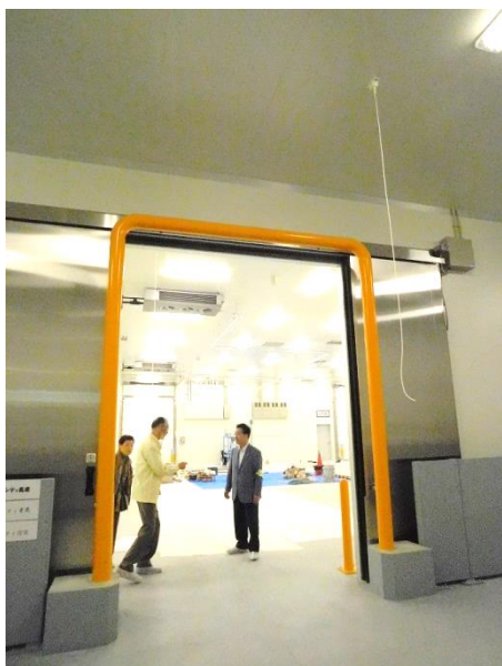
青果棟 三階 荷捌き場 手前のひもはドアを開閉するスイッチにつながっている。ひもを引けば、フォークリフトに乗ったままで開閉できる 建物外にトラックが横付けできる
